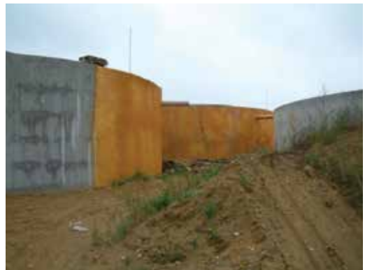
Figure III.5.5: Fermentor insulation (Nyírbátor, Bátortrade Kft.)
